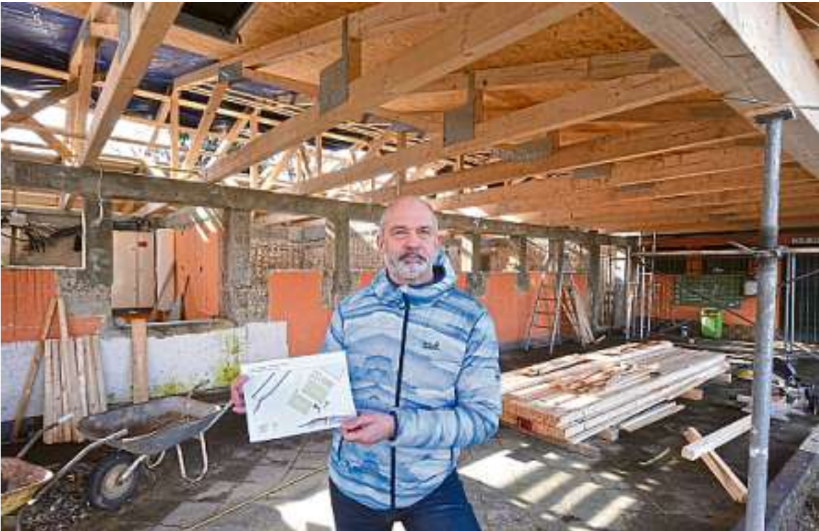
Der Vorsitzende des FC Kalbach, Reinhard Vanhöfen, auf der Baustelle. Die Umkleiden sind noch im Rohbau. In den Händen hält er einen Plan zur Erweiterung der Sportanlage.
